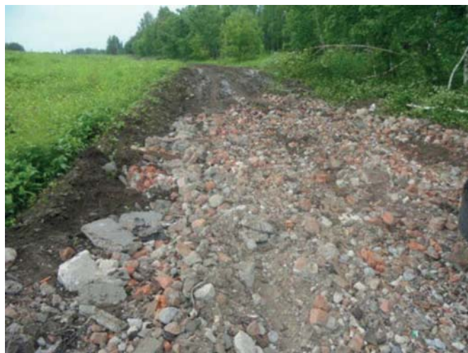
Рис. 43 — Перекрытие плодородного слоя почвы строительными отходами (окр. п. Заречный Томского района)
